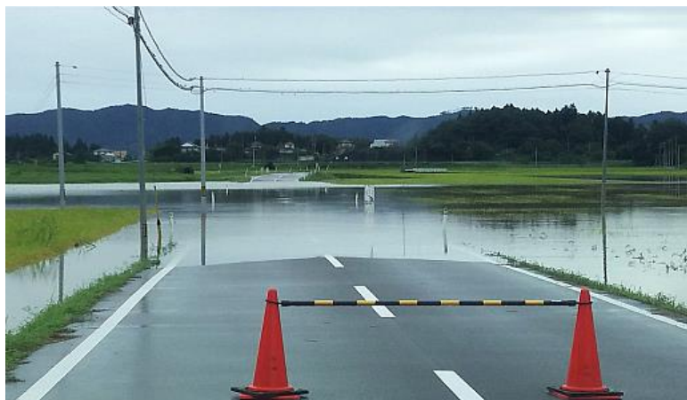
ゲリラ豪雨による道路の冠水
