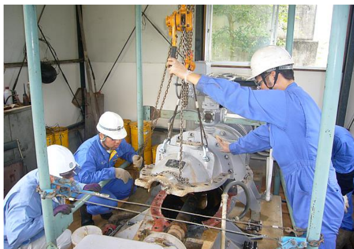
(株)谷工機社(施設点検共同実施・点検報告)
