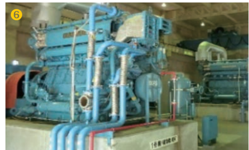
⑥原動機：現場整備、部品交換による改修
