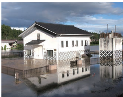
堀切排水機場 浸水
