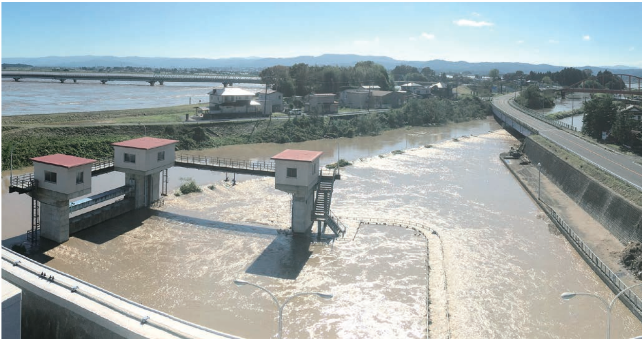
江尻排水機場 尾袋川と雑魚橋川の堤防を越水
