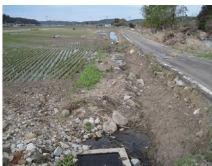
用水路への土砂堆積
