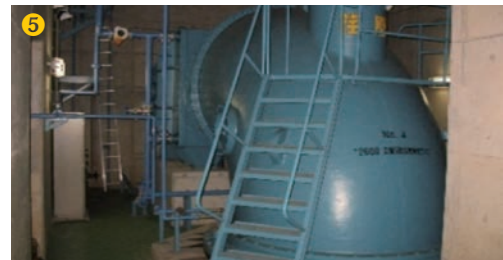
⑤ポンプ：工場整備、部品交換による改修
